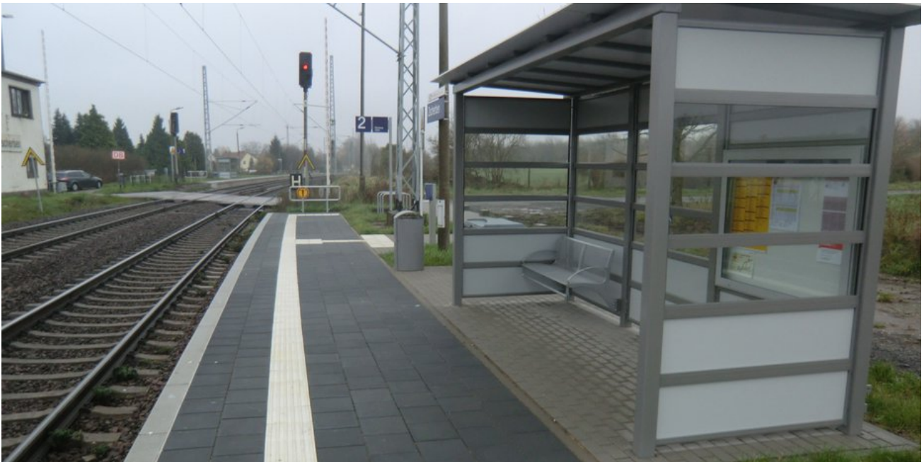
Die Bahnsteige haben nun neue Kanten und Bahnsteigbeläge
