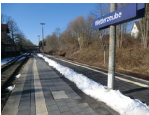
Moderner Bahnsteig mit Leitsystem
