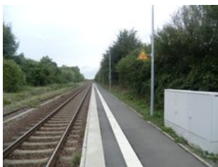
Bahnsteig mit neuer Oberfläche und Leitsystem
