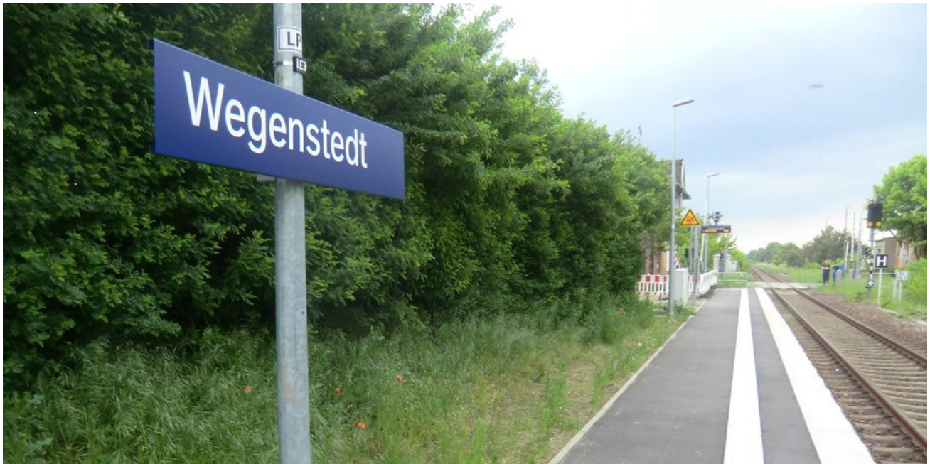
Bahnsteigerneuerung im Einfachhausbau
