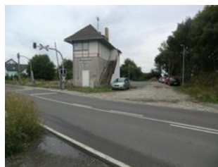
Zugangsbereich mit Pkw-Stellplätzen
