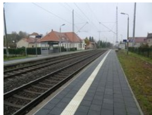
Beide Bahnsteige haben eine neue Oberfläche
