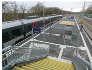
Die Fußgängerbrücke erhielt Schiebepuren für Fahrgäste, die ihr Rad mitnehmen möchten.
