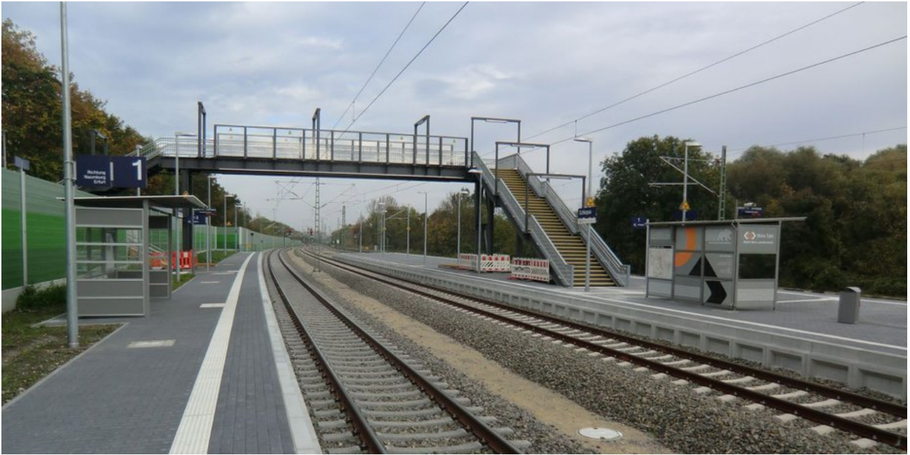
Im Oktober 2017 waren der Bau der neuen Fußgängerüberführung und der Bahnsteige abgeschlossen.
