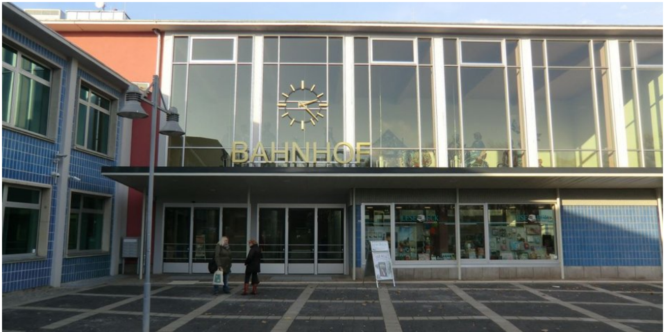
Seit November 2016 erstrahlt das Bahnhofsgebäude in neuem Glanz.
