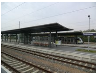
Seit September 2014 wurde gebaut, zwischenzeitlich sind die Bahnsteige, Aufzüge und Bahnsteigdächer fertiggestellt.
