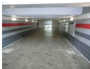
Die Modernisierung der Unterführung ist ebenfalls erfolgt.
