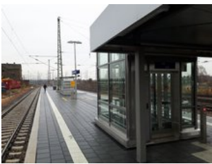
Der Mittelbahnsteig an den Gleisen 5/6 und die Verlängerung der Unterführung sind ebenfalls in Betrieb.
