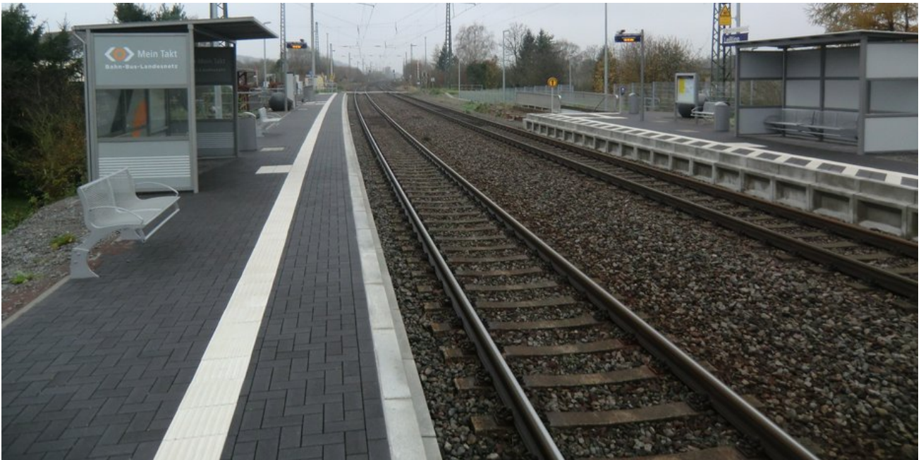
Die Bahnsteigerneuerung in Leißling wurde im Herbst 2014 abgeschlossen
