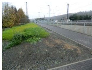
Barrierefreie Zuwegung vom Parkplatz zum Bahnsteig 2
