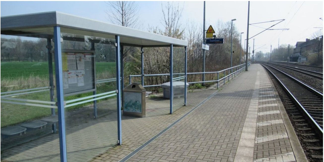
Beide Außenbahnsteige werden auf 155m verlängert und erhalten eine Bahnsteighöhe von 76cm.
