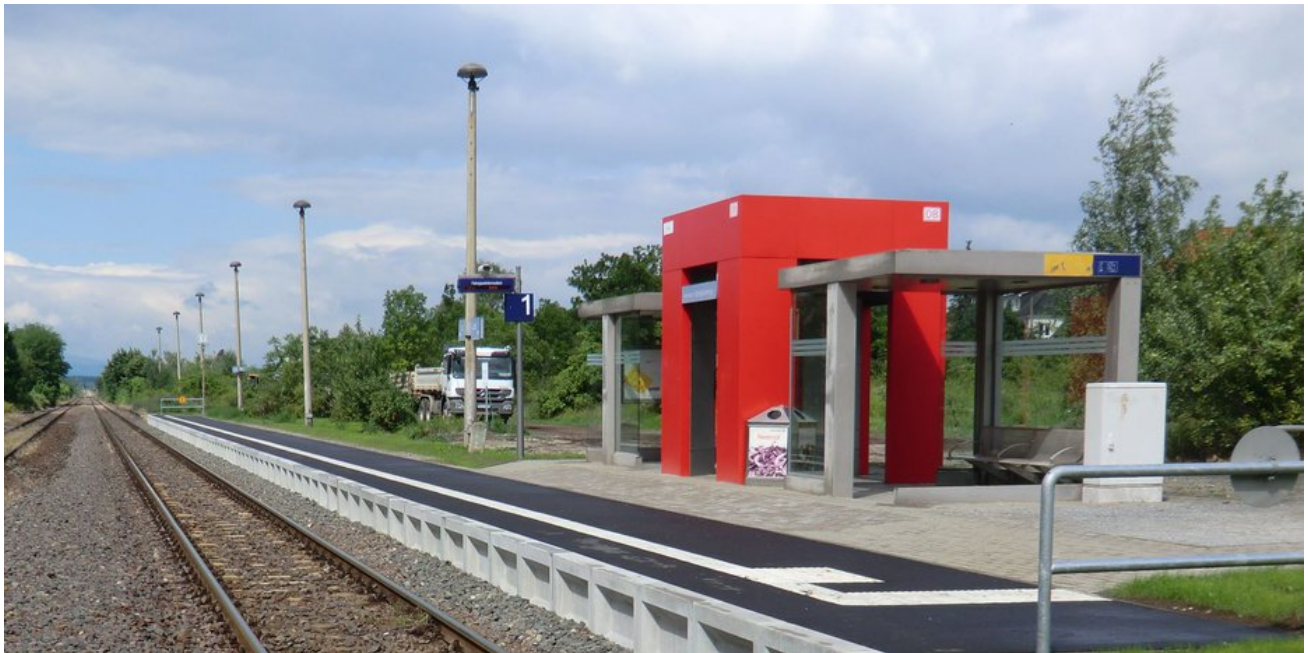
Bahnsteig mit neuer Kante
