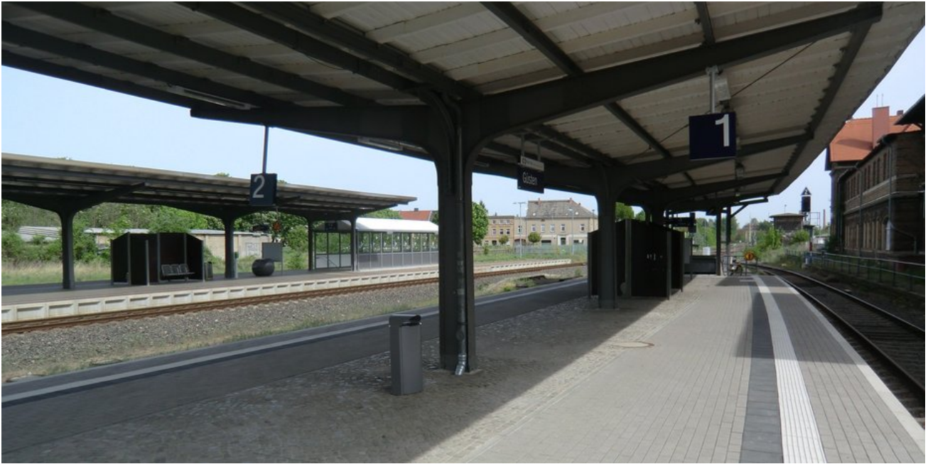
Der Bahnsteig 1-2 ist denkmalgerecht modernisiert
