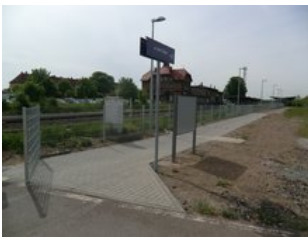
Direkter Zugang zum Bahnsteig 3 vom Bahnübergang
