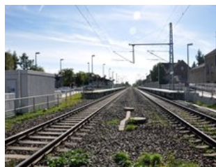
Bahnsteige direkt am Bahnübergang
