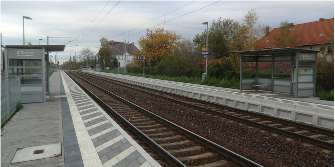
Zwei moderne Außenbahnsteige
