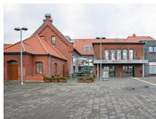
Die Rückansicht vom Bahnsteigende aus (Foto: Martin Limper, Bürgerbahnhof Cuxhaven e.G)
