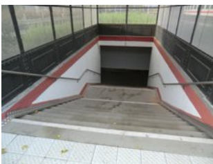
Die Unterführung konnte saniert und die Treppen mit Radschiebespuren ergänzt werden.
