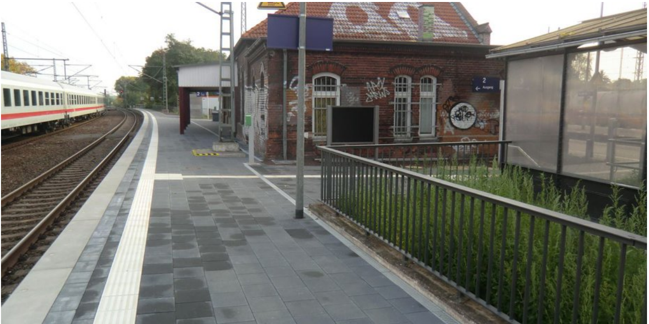
Im Spätsommer 2016 erfolgte der Abschluss der Bauarbeiten für die Bahnsteigmodernisierung.
