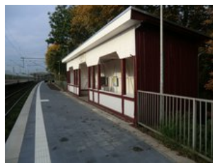
Die historischen Warteunterstände wurde fachgerecht saniert.
