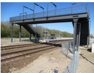
Die Bahnsteige sind durch eine neue Fußgängerbrücke erreichbar.
