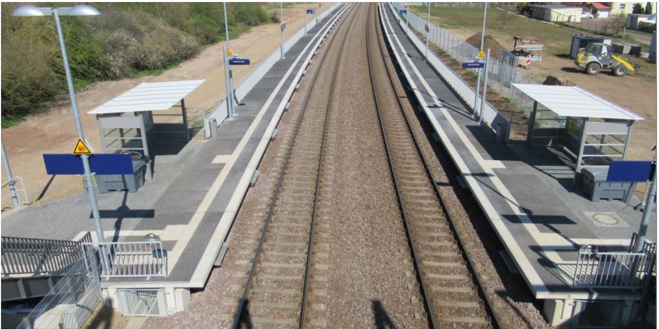
Im März 2020 gingen die beiden neuen Bahnsteige in Betrieb.
