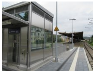
Seit Sommer 2021 ist der Aufzug zum Bahnsteig 2 in Betrieb.
