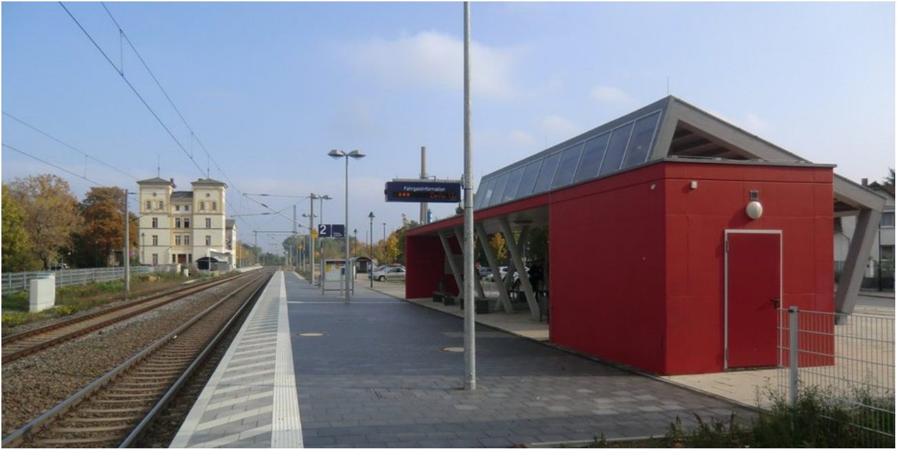
Bahnsteig mit Überdachung und WC
