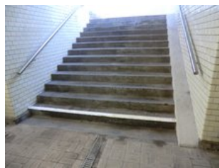
Die Treppen erhielten neue Handläufe und Radspuren
