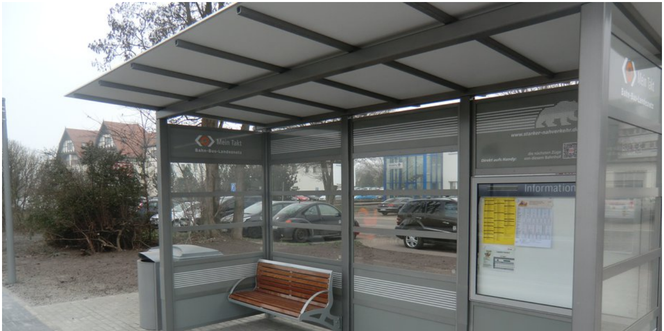
Neuer Wetterschutz statt alte Wartebude
