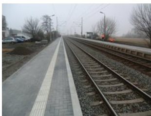
Moderne Bahnsteige mit Leitsystem
