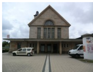
Der Bahnhofszugang vom Busbahnhof
