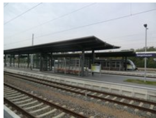
Seit September 2014 wurde gebaut, zwischenzeitlich sind die Bahnsteige, Aufzüge und Bahnsteigdächer fertiggestellt.
