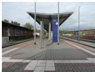
Bahnsteig mit saniertem Dach
