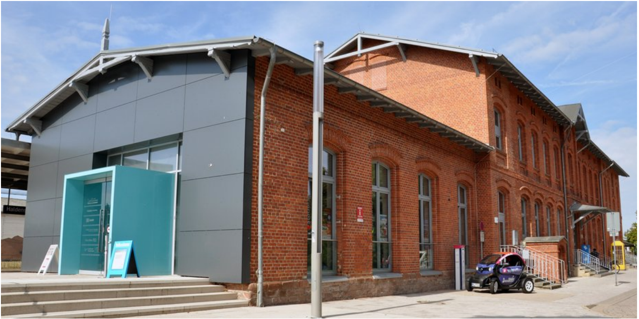
Sanierter Bahnhof mit neuem Zugang
