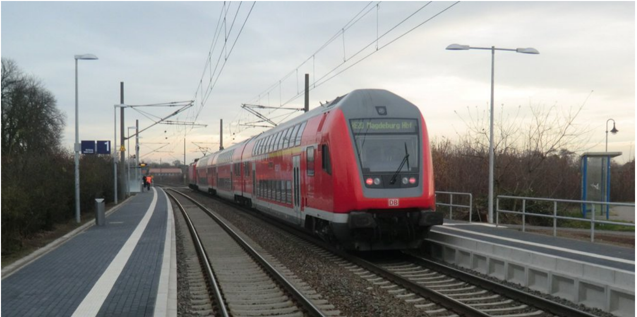
Der Neubau der beiden Außenbahnsteige ist beendet
