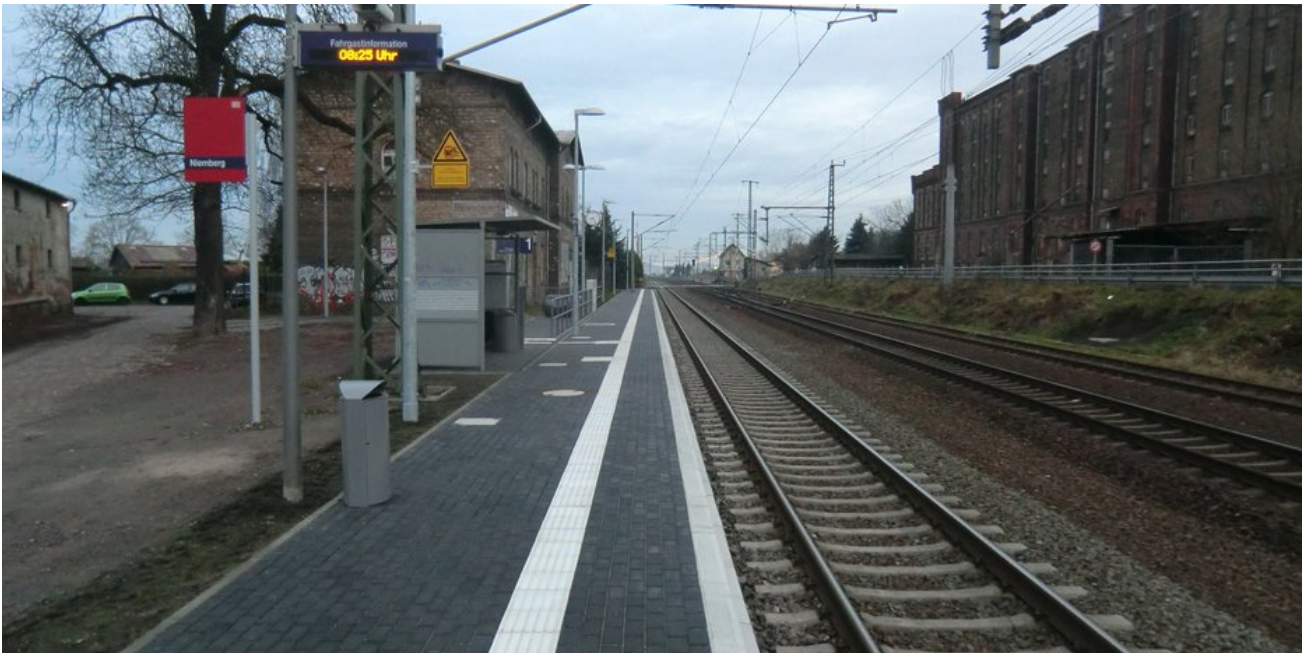
Die Erneuerung des Hausbahnsteiges wurde im Herbst 2014 abgeschlossen
