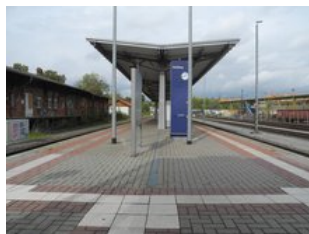
Bahnsteig mit saniertem Dach
